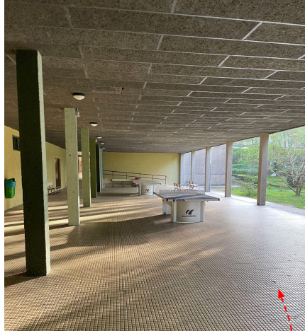
Patio de columnas
